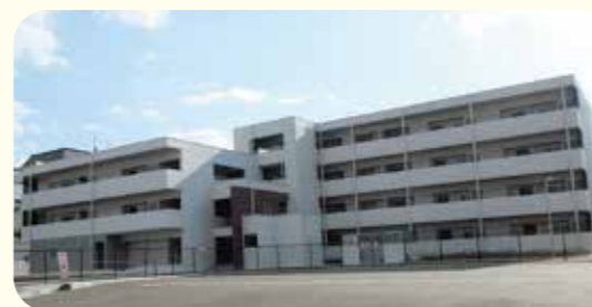
復興公営住宅茂庭第2
